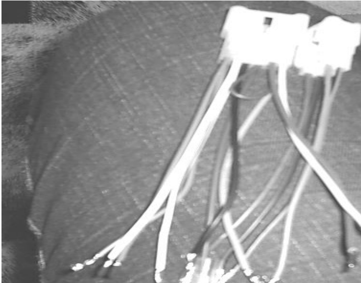
figura 4 - (Substituição de conexões oxidadas por novos conectores)
